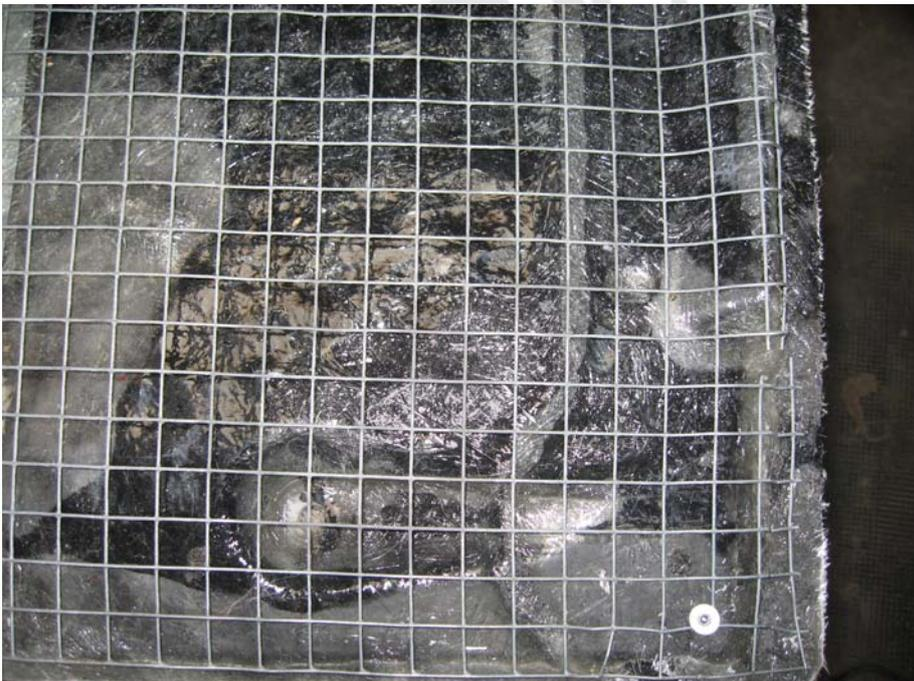
La rejilla de alambre se moldea y se mantiene en su posición mediante unos cuantos remaches. Posteriormente pasaremos a darle por encima una capa de poliuretano para que la siguiente capa de fibra adhiera mejor.
